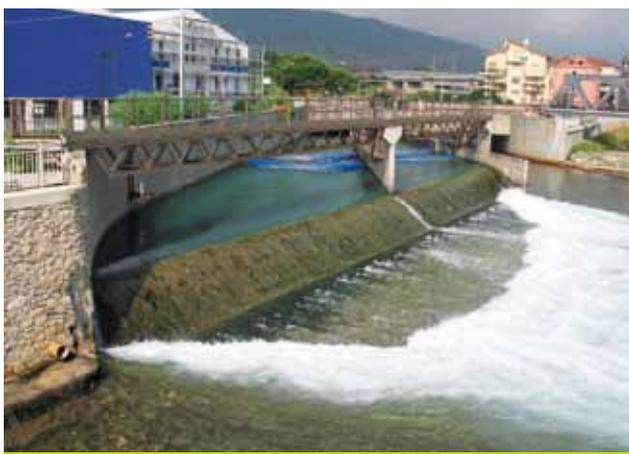
FIGURA n° 16: Opera di scarico acque reflue industriali e di raffreddamento
