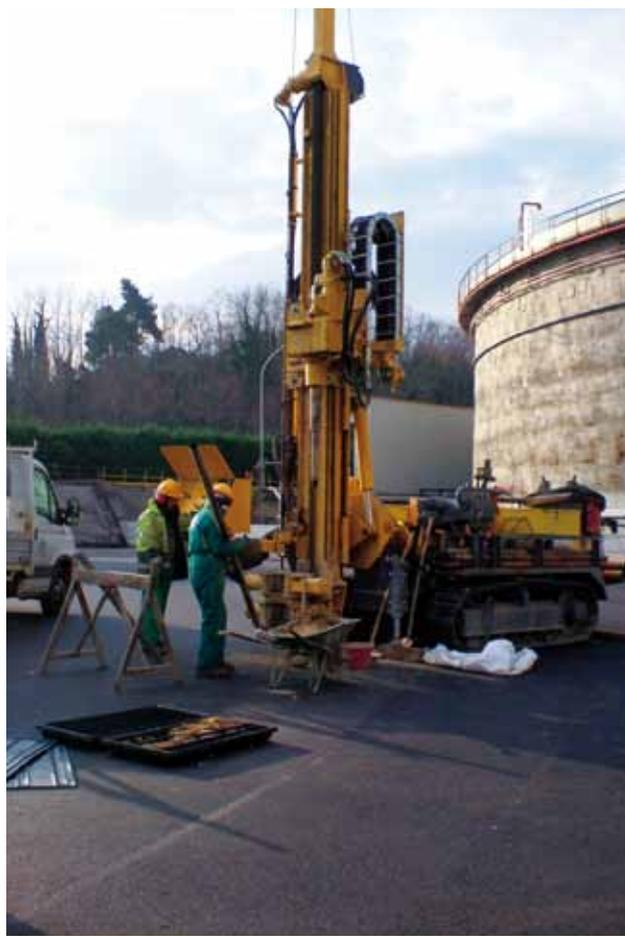
FIGURA n° 21: sondaggi geologici
