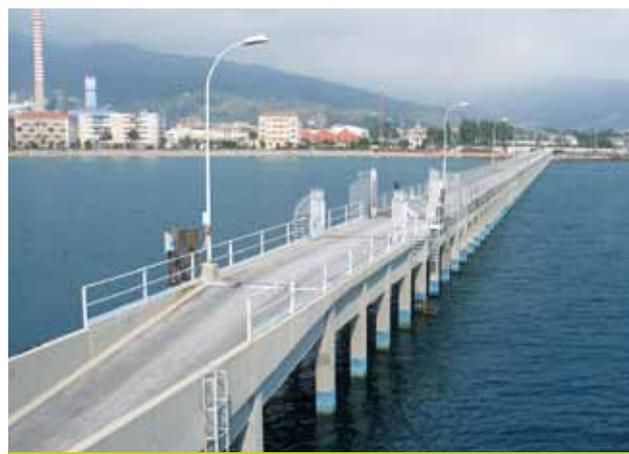
FIGURA n° 17: Opera di presa acqua di raffreddamento
