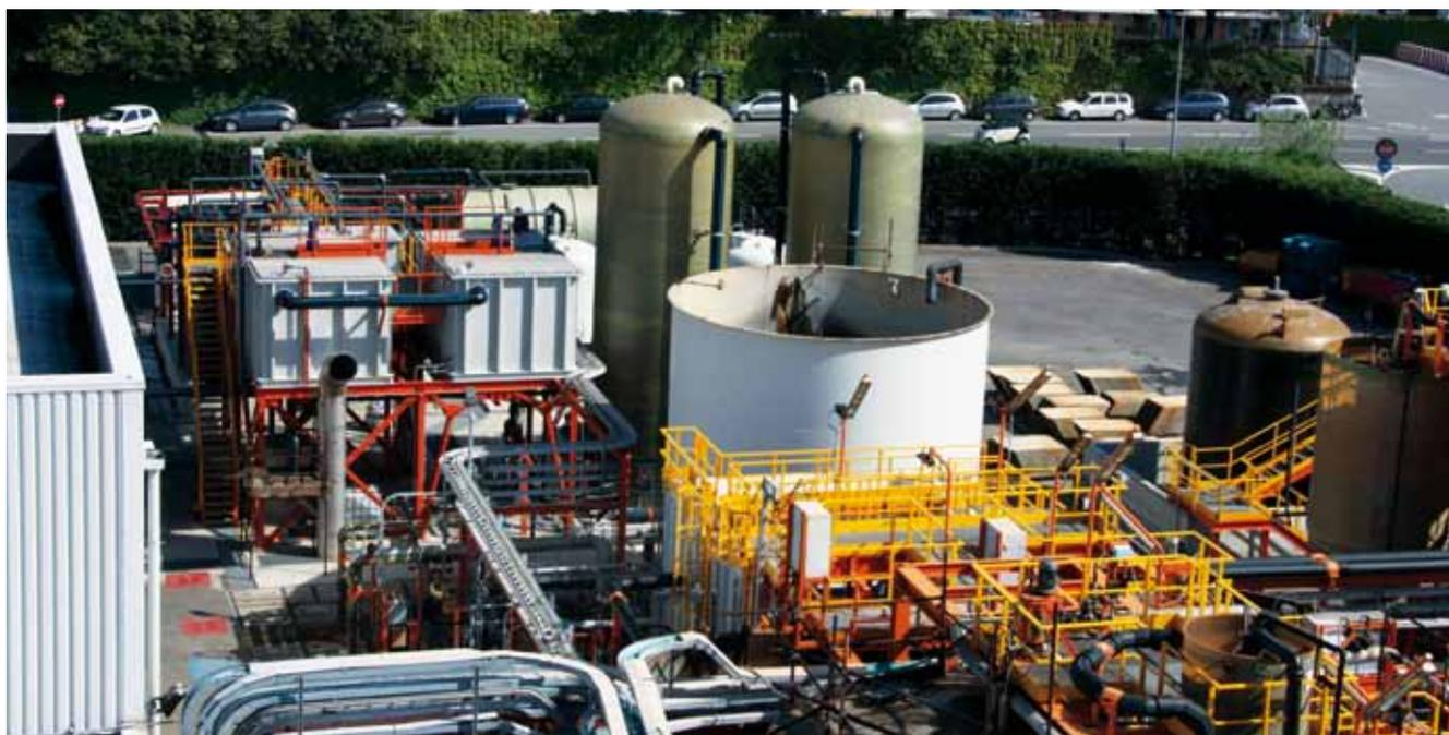
FIGURA n° 18: Impianto trattamento Spurghi Desolfurazione
