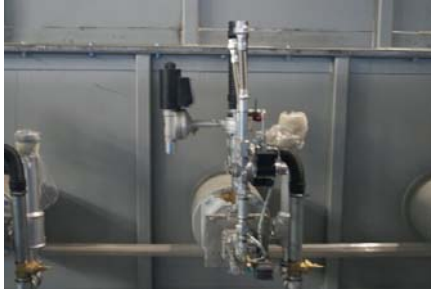
Particolare di bruciatore a metano e Syngas con recupero dei fumi
