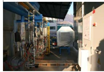
collaudo sicurezza impianto ATEX
