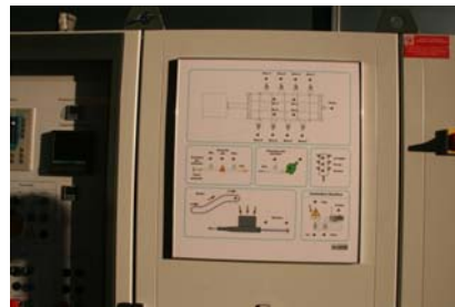
quadro comandi e PLC
