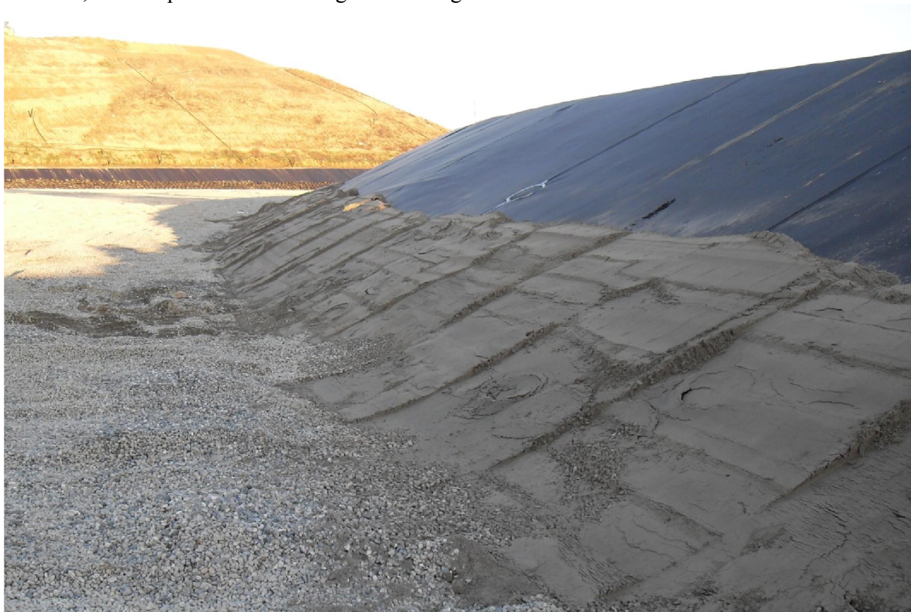
Figura 4-6. Esempio di rivestimento delle scarpate con pneumatici fuori uso intasati con inerti fini
